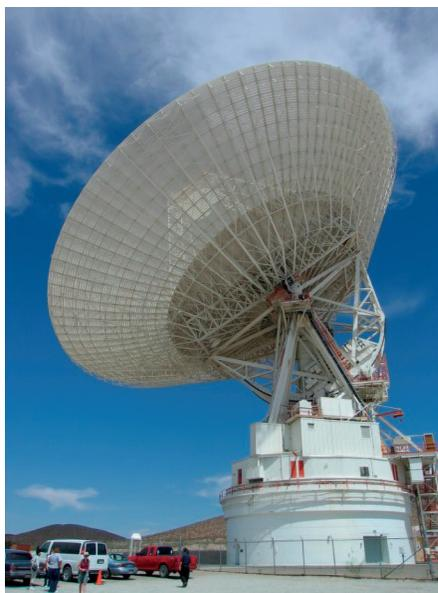
Рис. 1.3.4. Бистатическая РЛС «Голдстоун». Передающая и приёмная антенны
