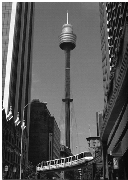
Еще один пример вантового сооружения: телевизионная вышка в Сиднее (Австралия). На ее фоне — монорельсовая дорога
