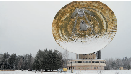
Станция дальней космической связи АО «ОКБ МЭИ» (Калязин), радиотелескоп ТНА-1500 диаметром 64 м, Российский комплекс приёма научной информации
