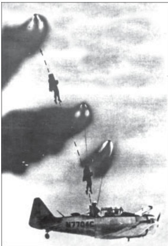
**Рис. 62.** Процесс катапультирования летчика с помощью ракетно-парашютной системы (РПС) с работающим буксировочным двигателем (БД) на начальном участке движения
