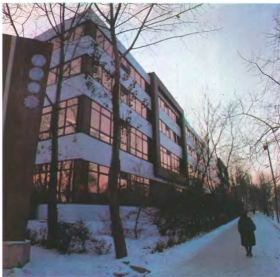
Главный корпус Особого конструкторского бюро Института космических исследований АН СССР в г. Фрунзе
