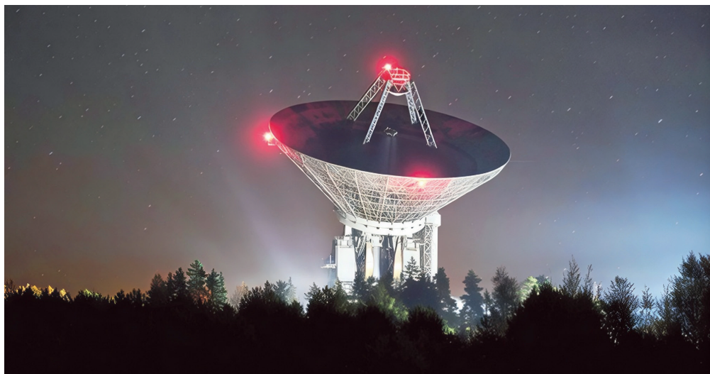
Рис. 14. Земная связь с небом: антенна диаметром 64 м наземной станции управления в Медвежьих Озерах. Именно через такие «тарелки» на Землю будут поступать бесценные данные от обсерватории, находящейся в десятках тысяч километров от Земли. © Александр Казаков/ТАСС
