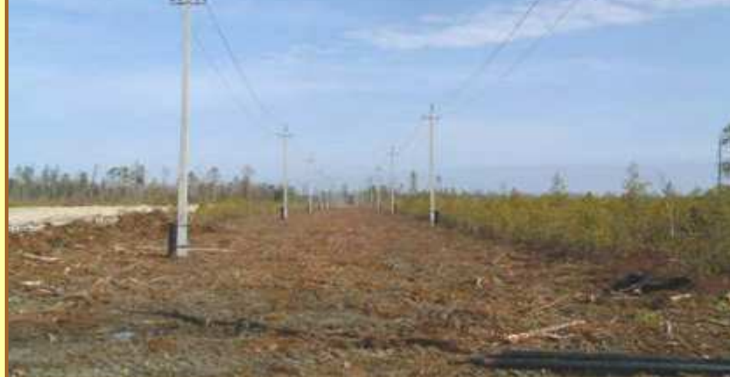
Установка линий электропередач
